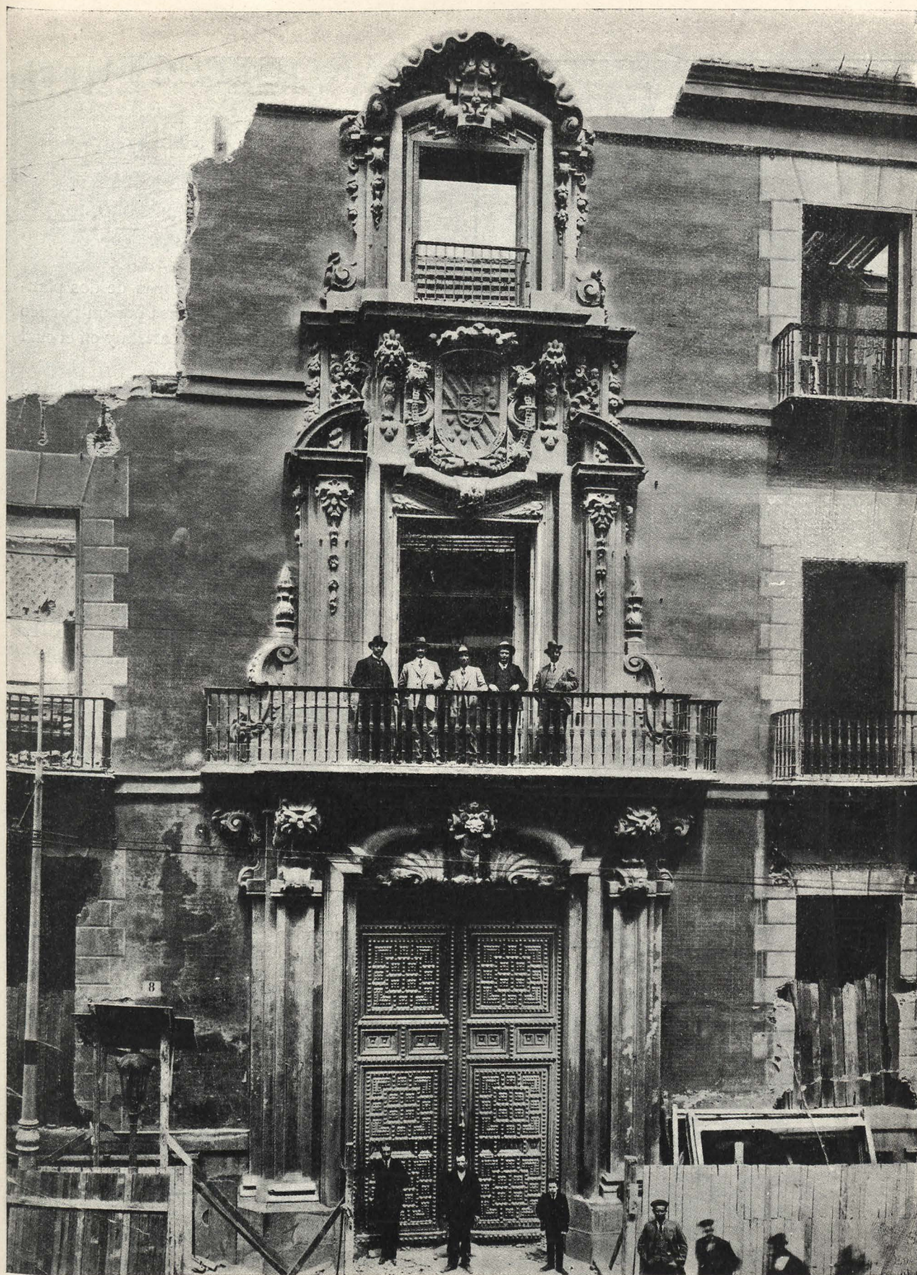
PUERTA DE LA CASA DE OÑATE, MADRID.
